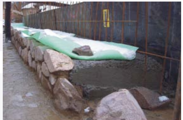
Bau Schwergewichtsmauer im Februar 2005
