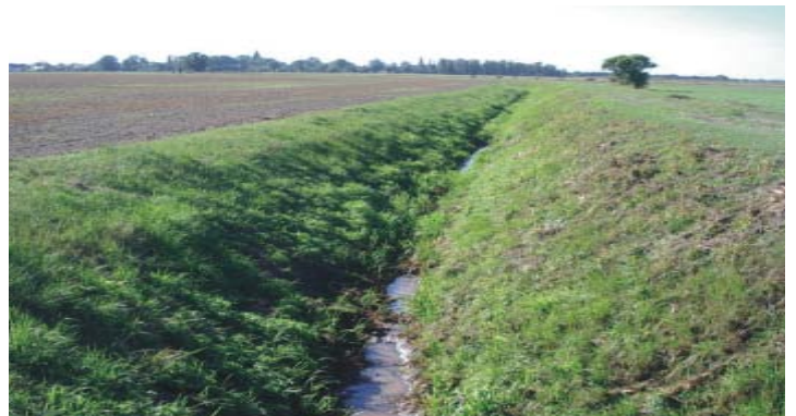
Die entwässernde Wirkung der viel zu tiefen Gräben führt zu einem permanenten Grundwasserentzug
